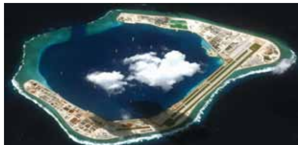
圖六：渚碧礁建設近照圖
