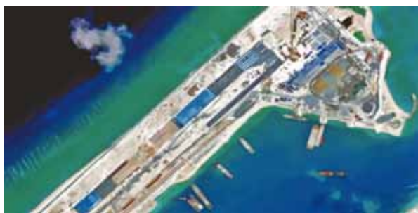
圖三：永暑礁機場俯瞰圖
