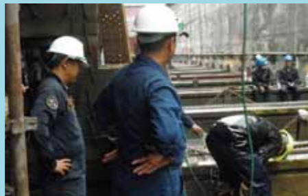
圖3 垂吊水管引乾淨水洗手兼洗臉洗身，反正雨衣內外都濕透了。
