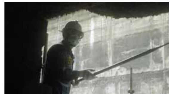
圖1 「海蠣子」包圍下，全副武裝包含護目鏡、棉紗手套、口罩，頭戴工作膠盔，身穿全件式雨衣，腳套工作靴，毛巾包覆露出的頸子。
