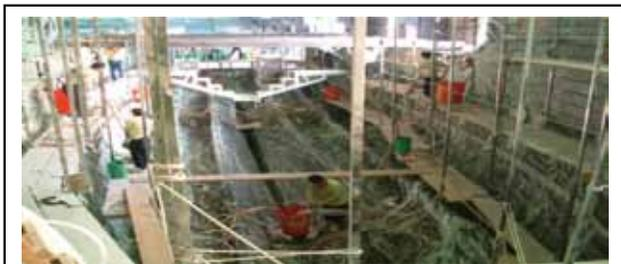
圖六 真空注入成型法施工狀況
